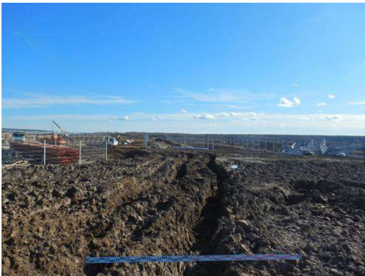
Илл. 10. Брянская область. Севский район. 2019 год. Обследованный участок. 1 - вид с СЗ (точка фотофиксации №7); 2 - вид с СЗ (точка фотофиксации №8).
