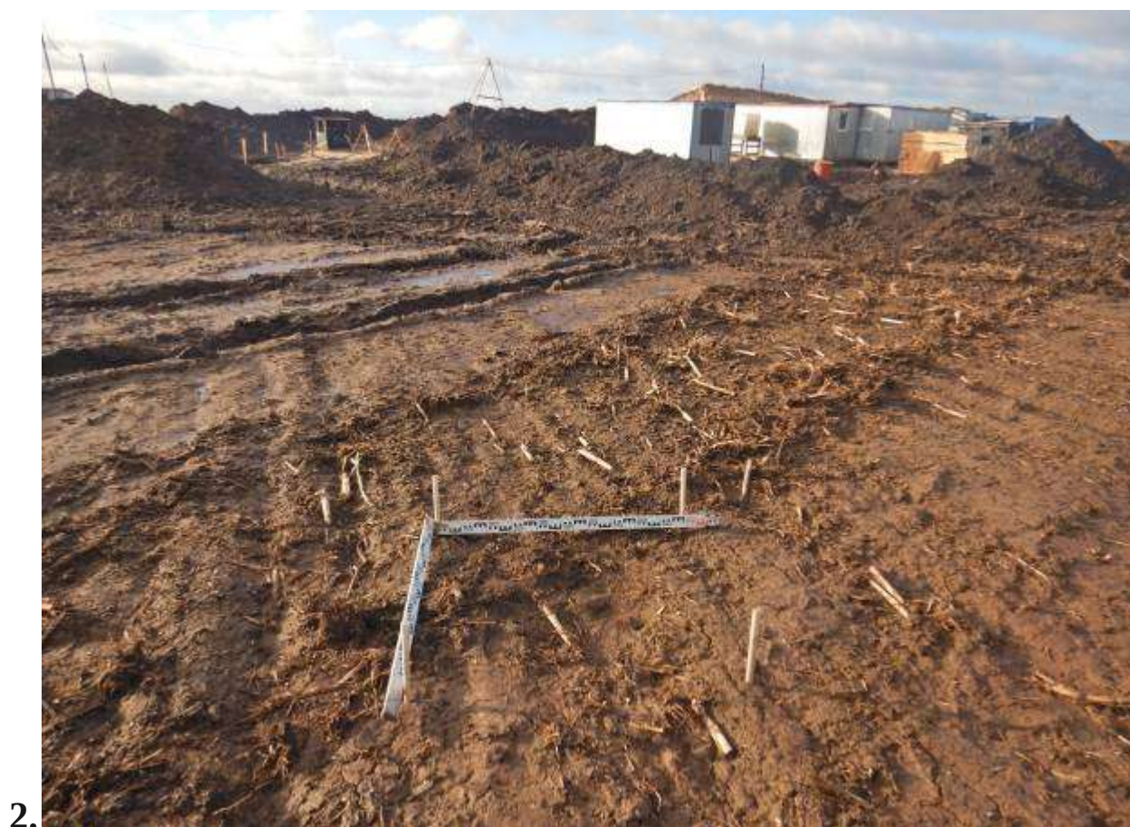
Илл. 16. Брянская область. Севский район. 2019 год. Шурф 1. 1 - место закладки, вид с С; 2 - дневная поверхность, вид с С.
